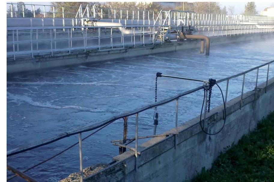
Рис. 1. Поточный датчик растворенного кислорода, установка на бортик аэротенка
